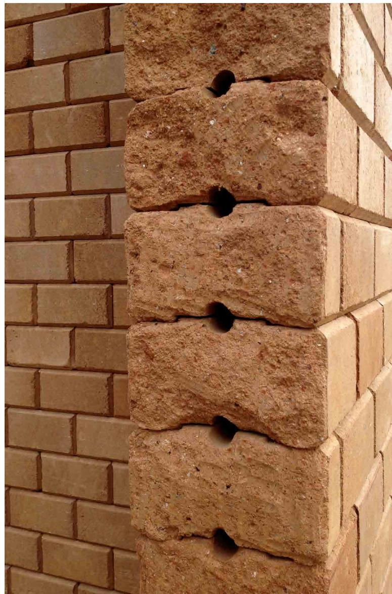
Mur réalisé avec des blocs autobloquants, Tiassalé.
