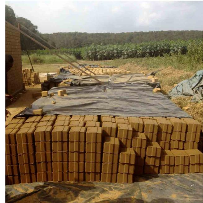
Fabrication des briques, séchage sous une bâche, Dabou.
